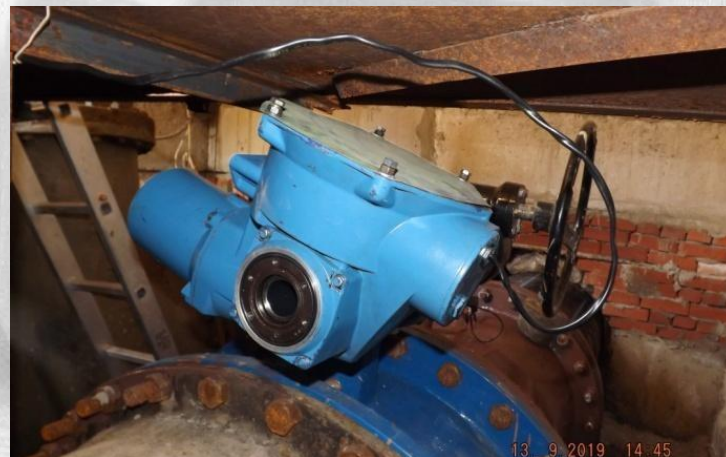
Фланцевый затвор с электроприводом (после устранения нарушения)
